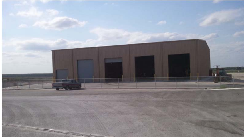
Figura 3 ESTACIÓN DE TRANSFERENCIA DE RESIDUOS SÓLIDOS MUNICIPALES DEL CONDADO DE STARR
